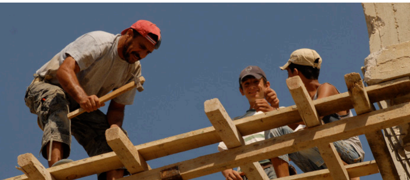
Construcción en Líbano © 2010 UNRWA Foto
